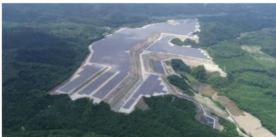
28-MW-Solarkraftwerk in der Präfektur Miyagi
